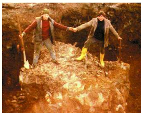
Gorostas izveden mlaznim injektiranjem (Pacchiosi - Italija)
