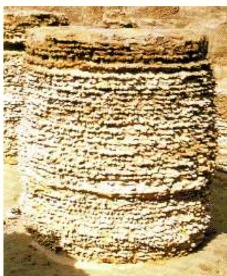
Snimak injekcijskog stupa izvedenog u tlu pogodnih karakteristika (Bauer)
