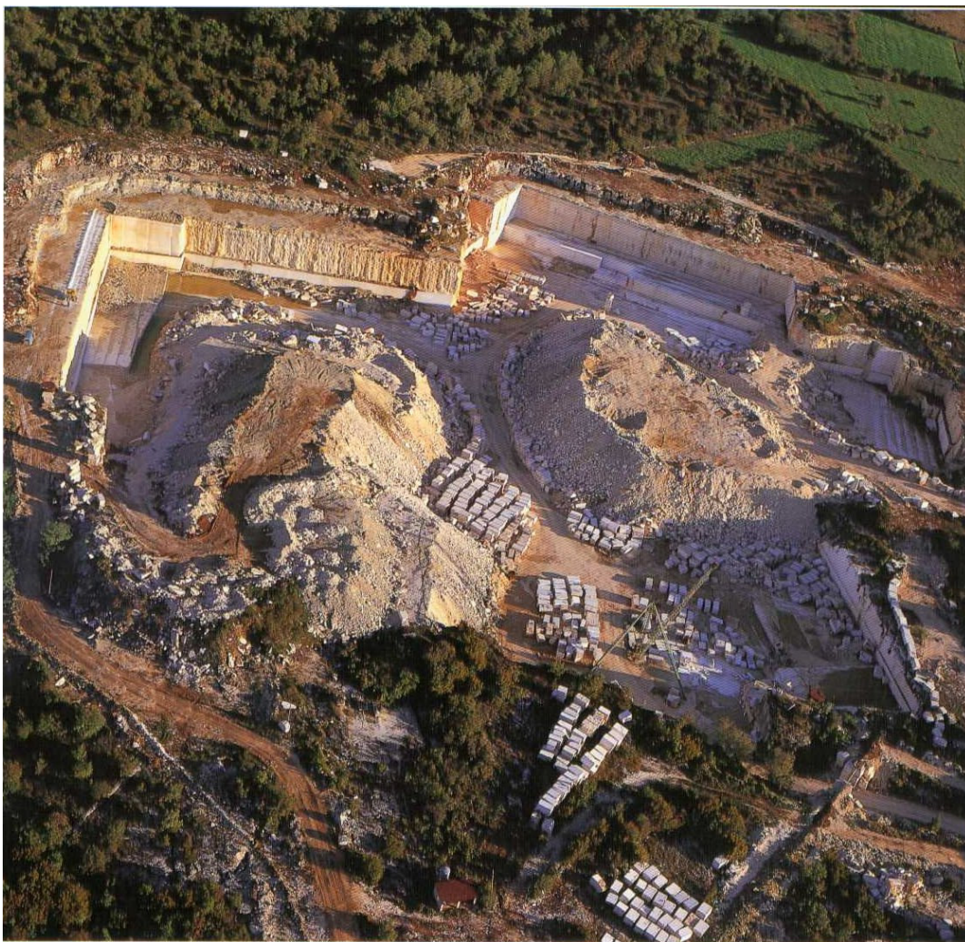
Slika 4.5. - Pogled na površinski kop Kanfanar
