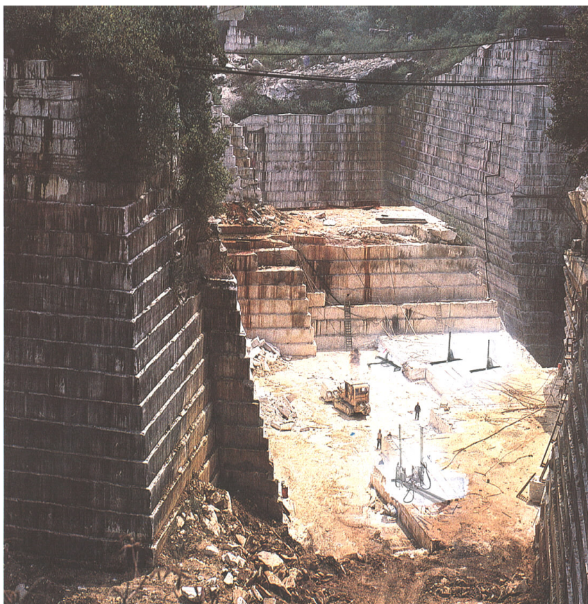
Slika 7.18. - Površinski dubinski kamenolom s karakterističnim obilježjem eksploatacije isključivim korištenjem lančane sjekačice
