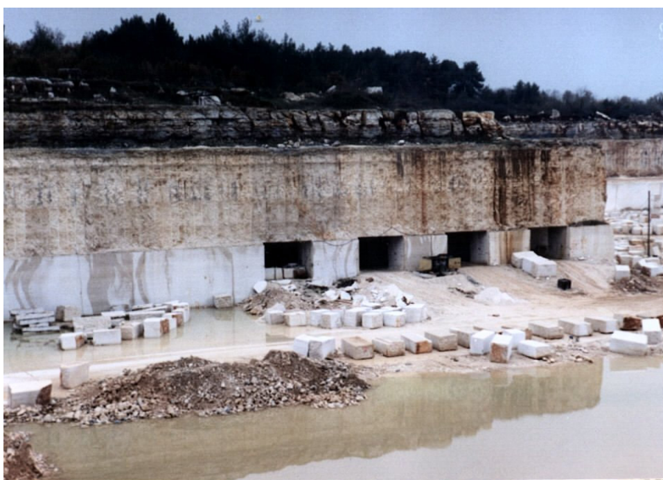
Slika 7.25. - Ulazne galerije podzemnog kopa Kanfanar
