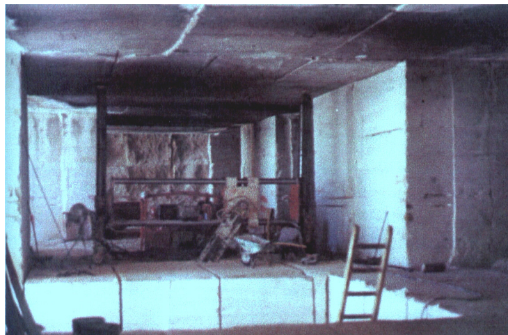
Slika 11.27. - Otvaranje donje etaže - piljenje vertikalnih rezova
