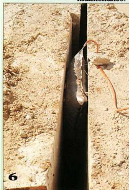
Slika 12.14. - Redosljed radnih operacija pri potiskivanju bloka vodenim jastucima
