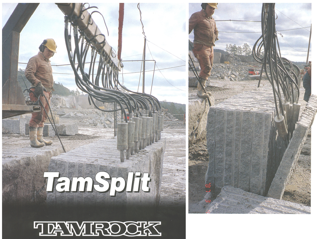
Slika 13.22. - Cijepanje granitnog bloka priključnom garniturom hidrauličnih klinova proizvod tvrtke Tamrock (Finska)
