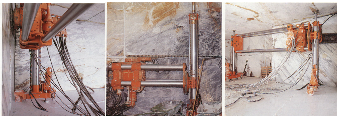
Slika 16.11. - Lančana sjekačica prilagođena za podzemno otkopavanje
