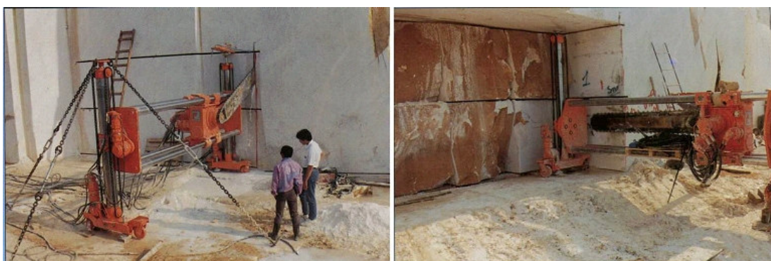
Slika 16.12. - Lančana sjekačica pri početnom otvaranju podzemnog kamenoloma
