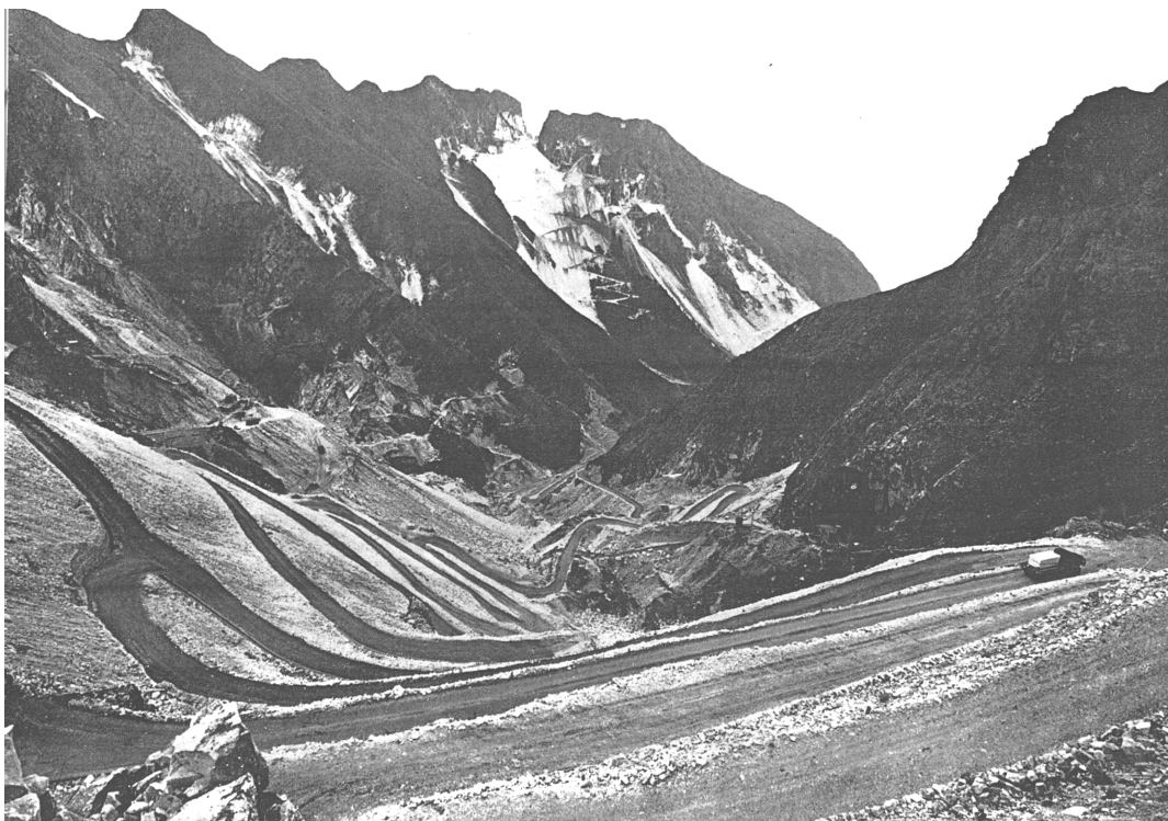
Slika 17.31. - Vezanje kamenolomskih cesta s ostalom cestovnom mrežom
