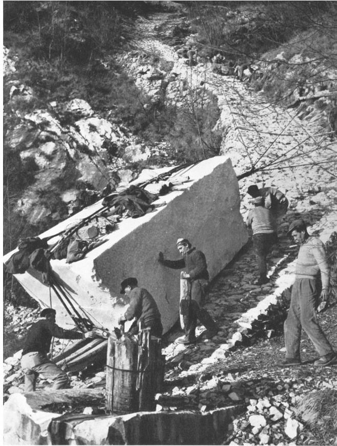
M. Altissimo - Lizzatura di un blocco da 9 m 3 di statuario (Soc. Henraux - Querceta di Lucca).
