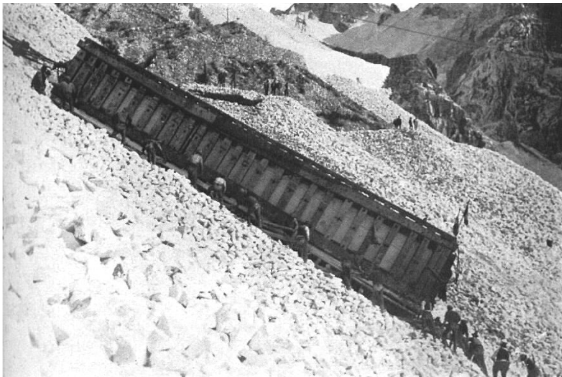
Abb. 13. Abtransport eines überdimensionalen Blockes im Gleitverfahren, (zu S. 44)
