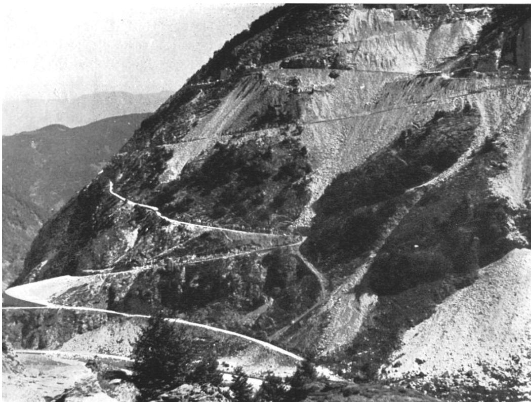
Via di lizza trasformata in strada. Cave di Vagli Piastra Bagnata (Soc. Montecatini).
