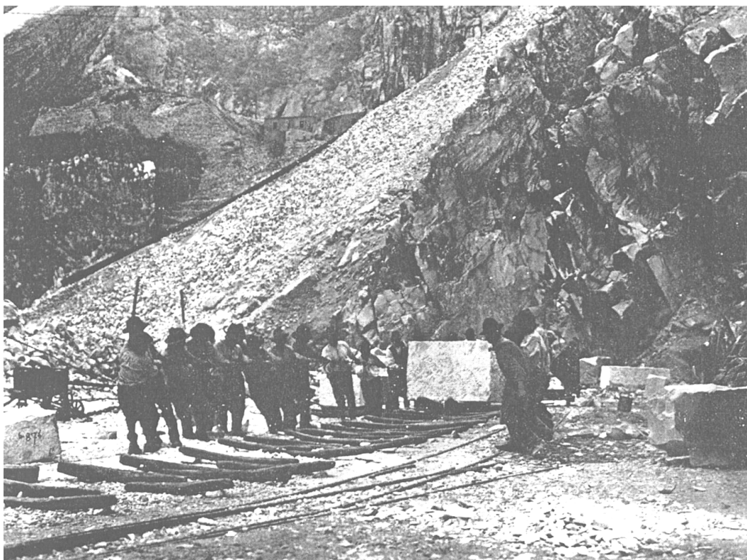
Slika 17.5. - Povlačenje bloka po oblicama na radnom platou (po horizontali) kamenoloma
