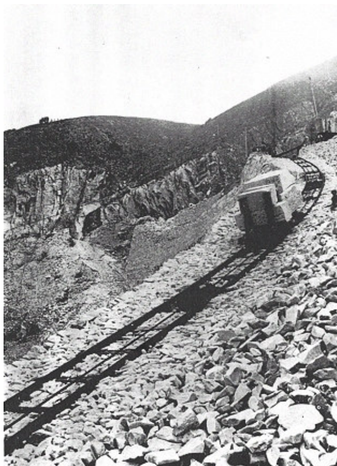
Slika 17.19. - Svladavanje blage krivine pri prijevozu otvorenim užetom
