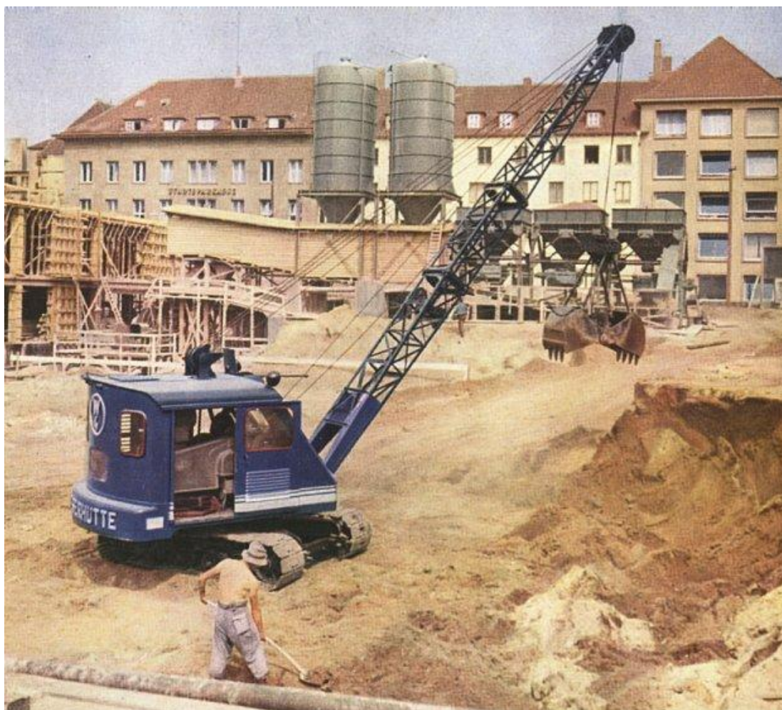
Slika 68 Bager grabilica – “grajfer” (Promidžbeni materijali tvrtke Weserhutte)
