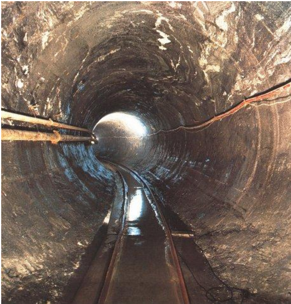
Slika 52 Izgled profila tunela nakon iskopa tunelerom
