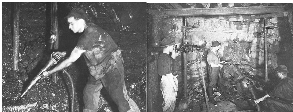
Slika 5 a) Primjena otkopnog čekića
