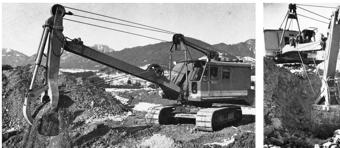
Slika 80 Iskop jaraka s bagerom s dubinskom lopatom
