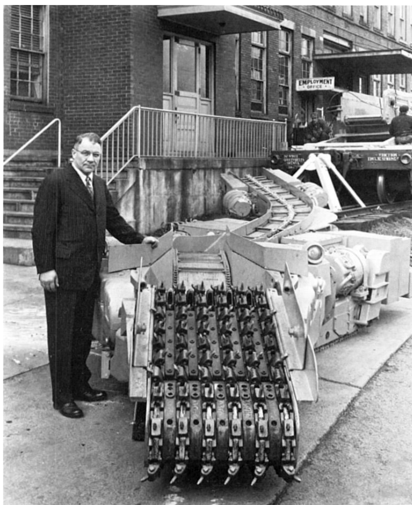
Slika 55 Stroj za kontinuirani punoprofilni iskop s reznim lancima (Harold Silver, 1940)
