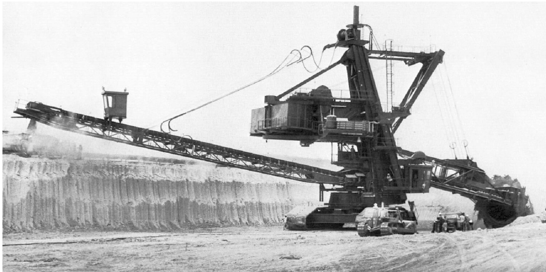
Slika 98 Otpremni transporter s gumenom trakom zavješen čeličnim užetima za glavnu konstrukciju sa stražnje strane bagera
